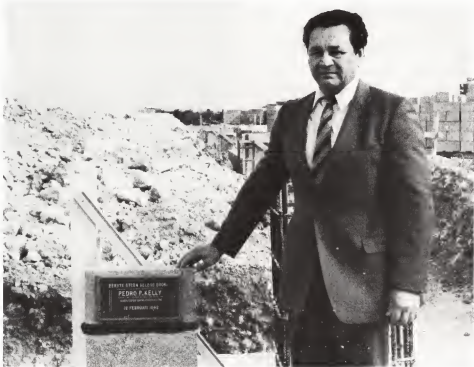
Dia 12 di Februari ultimo Diputado pa asuntonan di Vivienda, Sr. Pedro Kelly a pone e prome piedra pa e edificio di F.C.C.A. na Sabana Blanco. Cu realisacion di e edificio aki, e empleadonan di F.C.C.A. ta haya facilidnan adecuado pa brinda e pueblo di Aruba mihor servicionan.
